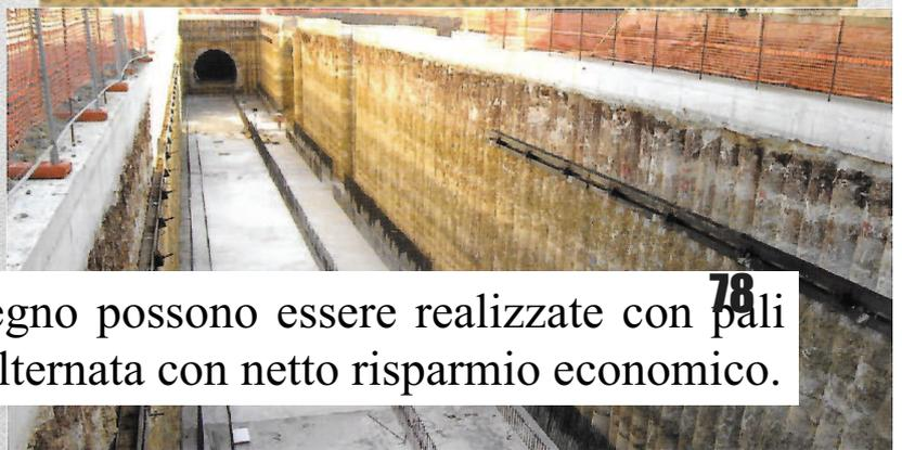
Le palificate di sostegno possono essere realizzate con pali concatenati ad armatura alternata con netto risparmio economico.
